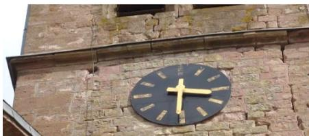
Aufgrund von Beschädigungen an der Turmaußenwand (Westseite), die unter anderem durch Schwingungen entstanden sind, die sich beim Läuten vom Glockenstuhl auf das Mauerwerk übertragen, müssen wir die Läuteanlage auf unbestimmte Zeit außer Betrieb nehmen.
