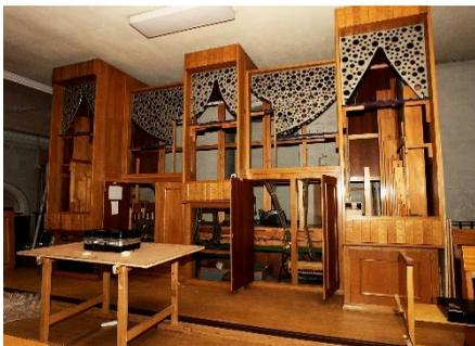
Sämtliche Pfeifen des Orgelwerkes werden ausgebaut, zerlegt und in die Orgelwerkstatt in Heusweiler transportiert. Dort werden alle Schäden am Pfeifenwerk, wie Risse und Beulen fachmännisch repariert.
